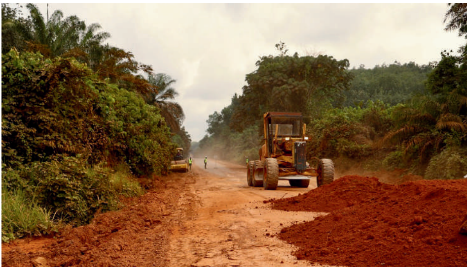
△ Réhabilitation d'un tronçon de la route côtière par la SOGB
