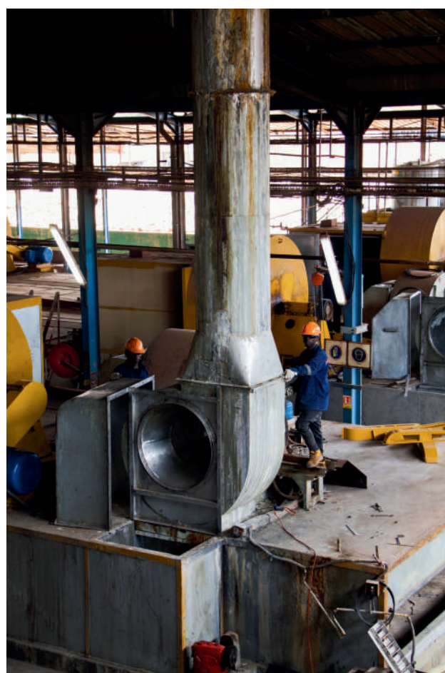
△ Équipe de maintenance du CCC, lors de la révision annuelle en avril 2025
