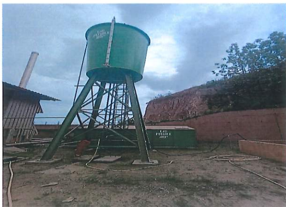
Une vue de la réserve d'eau
