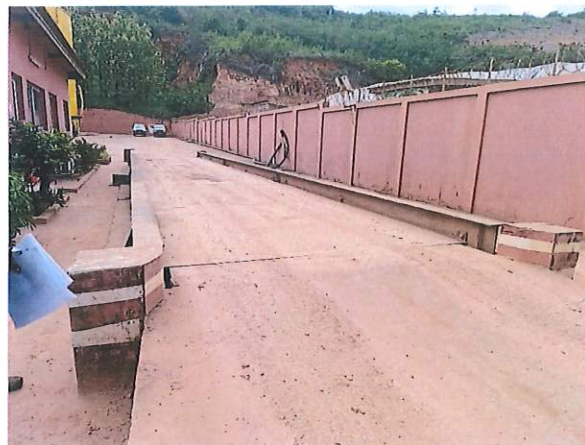
Une vue du pont bascule
